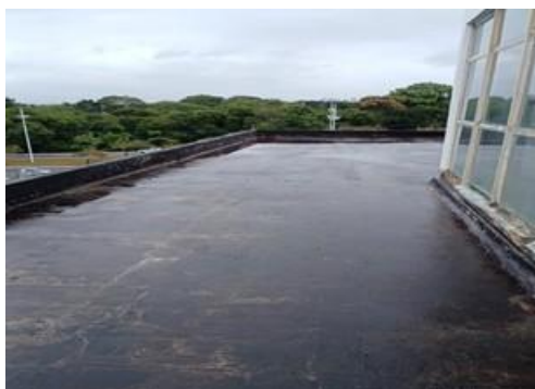
Figura 6: Aplicação de primer em trecho da laje 1
