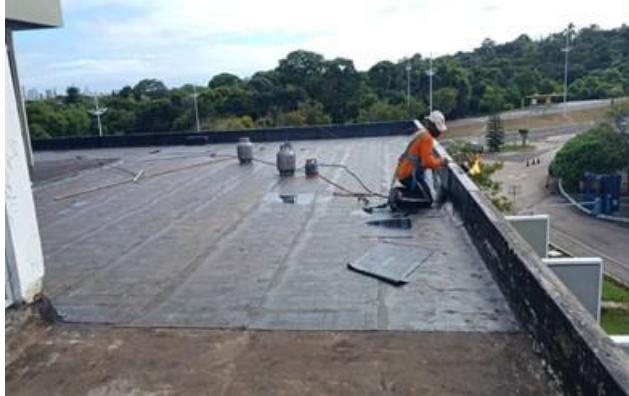
Figura 7: Aplicação da manta asfáltica em substrato
