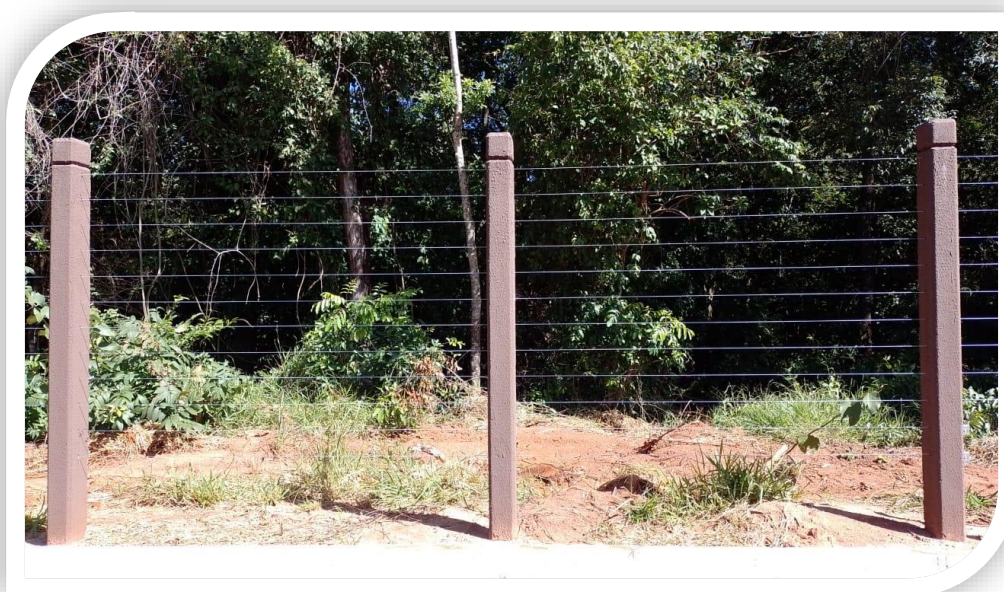
Figura 10 – Passagem de fauna – cercamento para animais de pequeno porte
