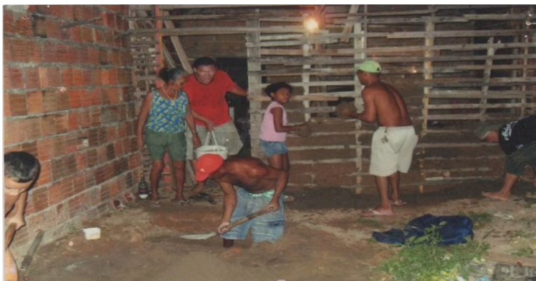
Figura 8 - moradores construindo suas moradias coletivamente.
