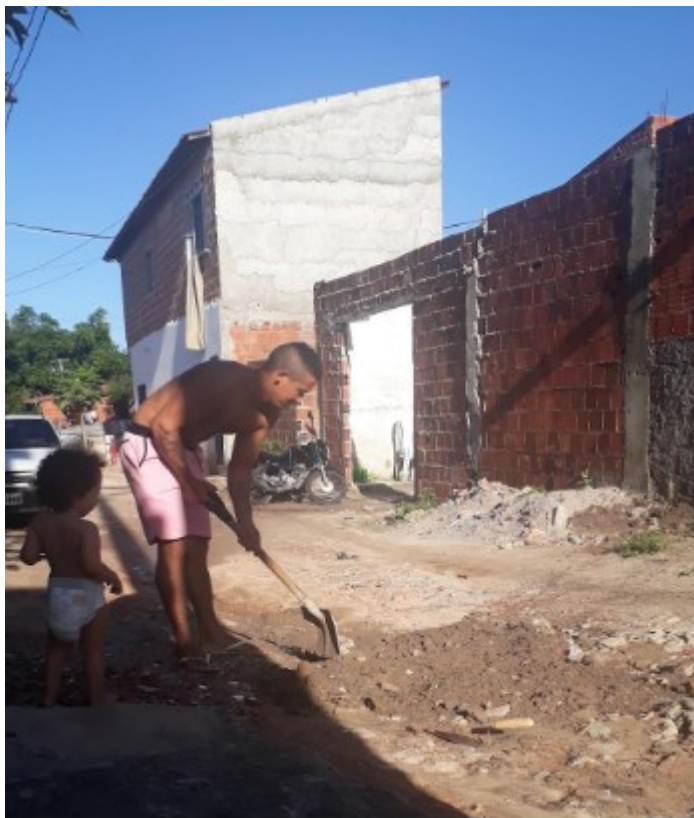
Figura 9 - Morador da comunidade realizando reparo de um cano exposto em frente a sua residência, após ter afetado o abastecimento de água dos vizinhos (fev., 2022).
