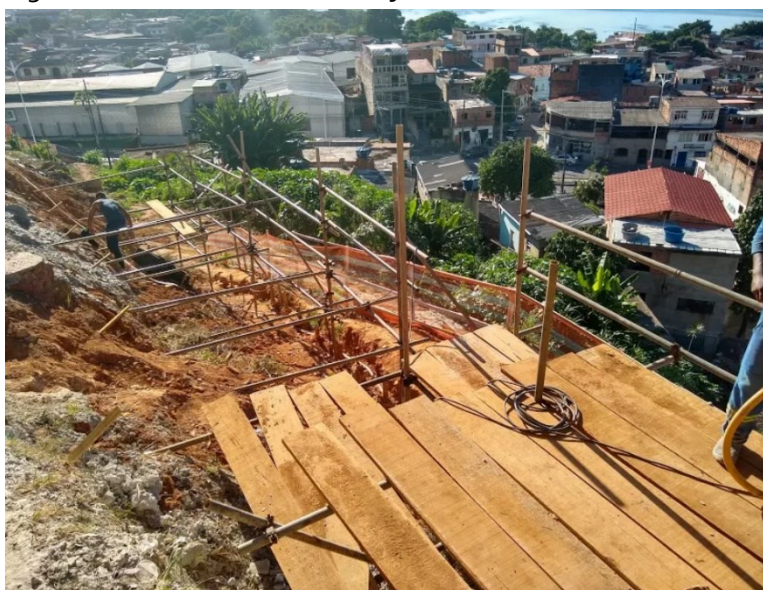
Figura 2 – Maria Isabel - CONTENÇÃO DE ENCOSTAS
